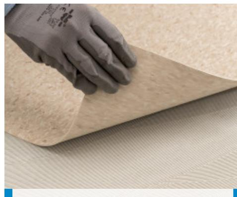
Verlegung von homogenen PVC-Belag mit **Ultradond Eco V4 Evolution**
