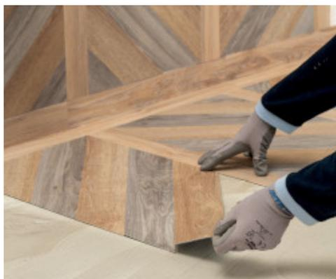
Verlegung von modularem LVT-Belag mit **Ultradond Eco V4 Evolution**
