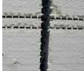
Trennschnitt in den Dämmstoff
