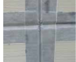
Ausführung mit Dichtband
