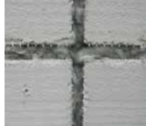
Ausfüllen mit Dämmstoff
