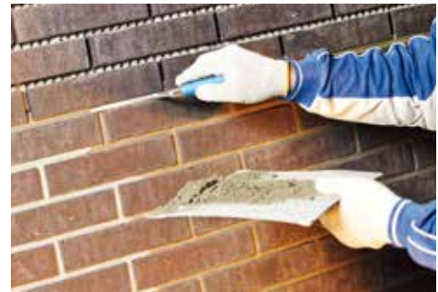
Verfugen im Fugeisenverfahren
