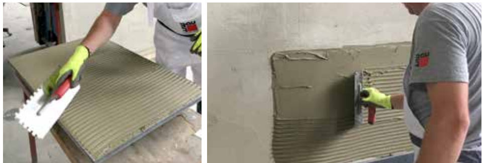
Verkleben im Buttering-Floating-Verfahren mit Baunit CeramicFix
