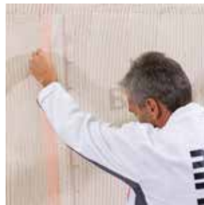
Einlegen des Armierungsgewebes Baumit StarTex grob
