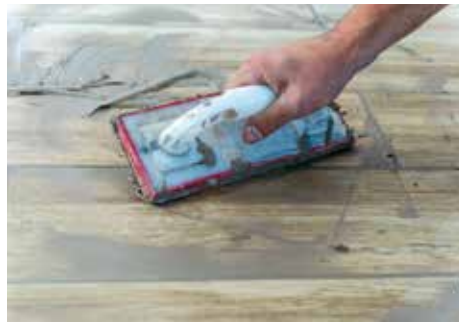
Verfugen im Schlämmverfahren
