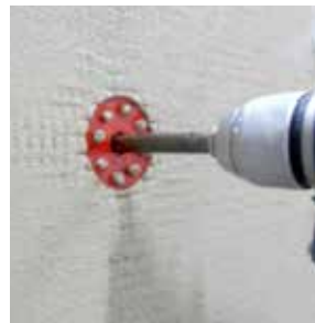
Verdübelung mit Baumit Schraubdübel
