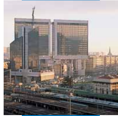
Verlegung von 10.000 m 2 Teppichboden mit Aquacol T im Corte Lambruschini in Genua
