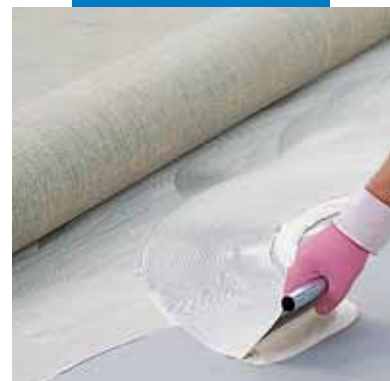
Auftragen von Aquacol T bei der Linoleum-Verlegung
