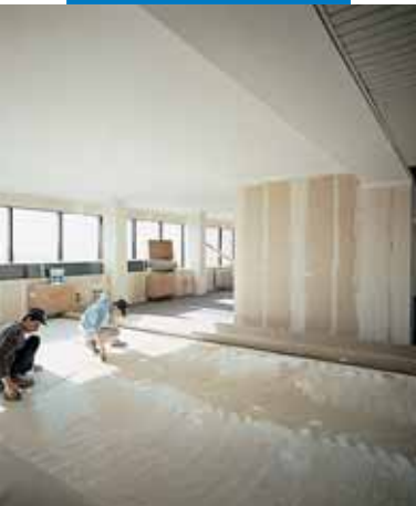
Auftragen von Aquacol T bei großflächigen Verlegungen
