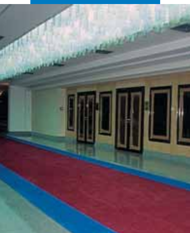
Verlegung von textilen Bodenbelägen im Korridor eines öffentlichen Gebäudes - Italien
