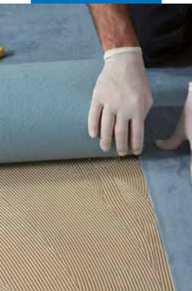
Verlegung eines Textilbelages
