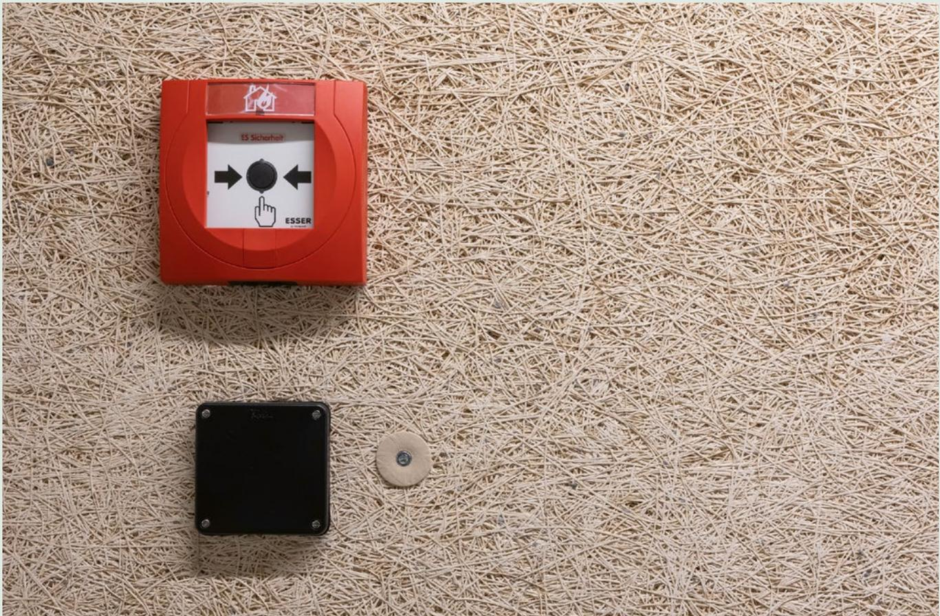
Eine Montage von leichten Gegenständen wie z.B. Leuchten, Rauchmeldern, Leitsystemen, Hinweisschildern oder Leerrohren an Decken und Wänden kann unter Verwendung von Metall-Trockenbaudübeln direkt in die Holzwoll-Deckschicht (ausgenommen Duro-P) unserer Unitex Typ 2 Platten erfolgen. Die maximale Zuglast beträgt hierbei 2 kg je Befestigungspunkt.
