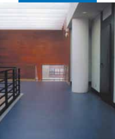
Beispiel einer Linoleumverlegung auf einem mit Ultraplan gespachtelten Untergrund. Monzon - Konservatorium - Spanien
