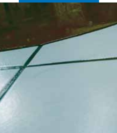
Detail zur Verarbeitung von Ultraplan auf dem vorab grundierten Keramikbelag
