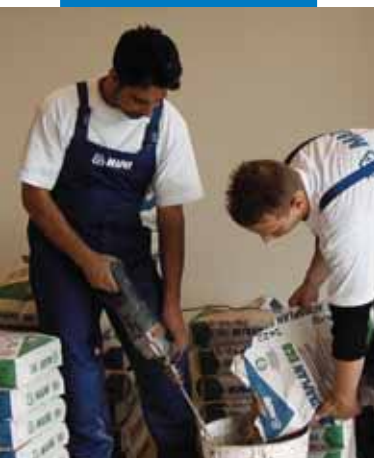
Anmischen von Ultraplan Eco - Kindergarten Mirabello - Cantù (Como) - Italien
