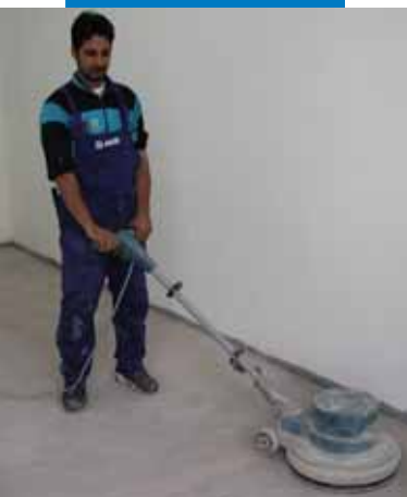
Anschleifen des Untergrundes vor der Spachtelung mit Ultraplan Eco - Kindergarten Mirabello - Cantù (Como) - Italien
