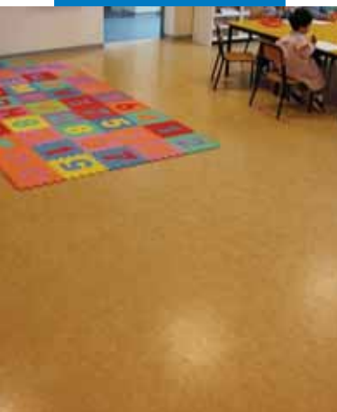
Linoleum verlegt auf einem mit Ultraplan Eco gespachtelten Untergrund - Kindergarten Mirabello - Cantù (Como) - Italien
