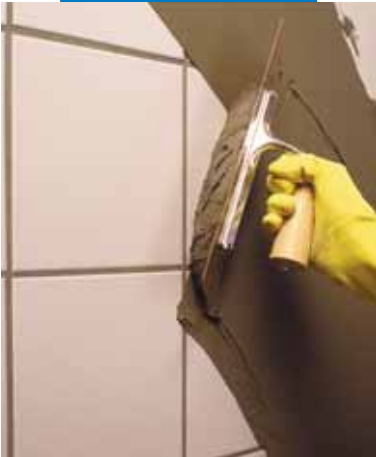
Spachtelung von gereinigten Altbelägen mit Planipatch
