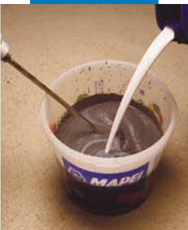
Anmischen von Planipatch mit Latex Plus zur Spachtelung verformungsfähiger Untergründe
