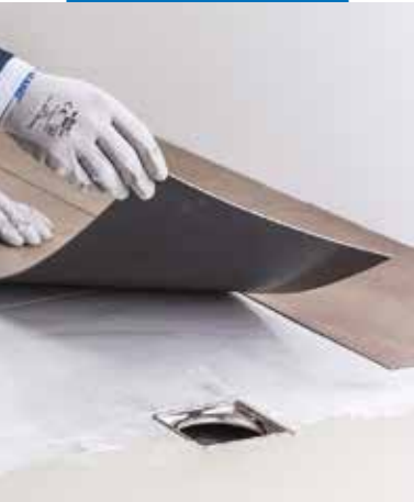
Verlegung von Designbelägen (LVT) mit Ultrabond Eco MS 4 LVT in Nassbereichen
