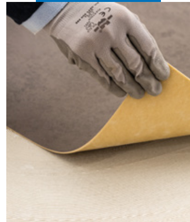
Verlegung von PU-Belag mit Ultrabond Eco V4 Evolution
