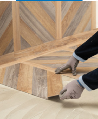
Verlegung von modulare LVT-Belag mit Ultrabond Eco V4 Evolution
