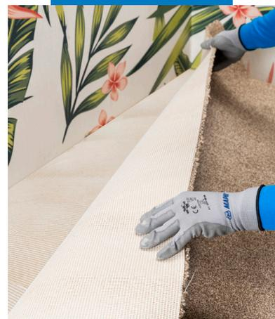
Verlegung eines Teppichbodens auf der Dämmunterlage (Kontaktklebung)
