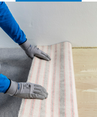
Verlegung von Tuftingbelag
