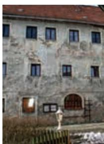
Vor größeren Instandsetzungsmaßnahmen, wie dem Einsatz eines Sanierputzsystems, muss die Bausubstanz bewertet werden. Vor-Ort-Termine klären die notwendigen Untersuchungen zur Dokumentation von Daten, Klima und Proben für Laboranalysen.
