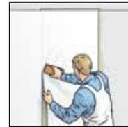
**5.** Die Bahnen Naht an Naht im Lot verkleben. Blasen- und faltenfrei mit Tapezierbürste oder Gummirolle andrücken.
