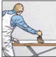
**2a.** Einkleistern per Hand: Bahnen in Wandhöhe plus Zugabe zuschneiden und einzeln einkleistern. Oder
