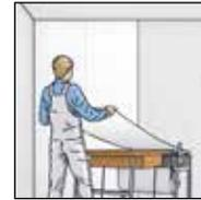
**2b.** Einkleistern per Kleistergerät: Bahnen durch das Kleistergerät ziehen und abschneiden.
