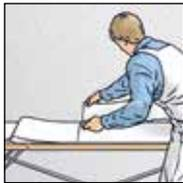
**3.** Die eingekleisterten Bahnen werden 2/3 zu 1/3 zusammengelegt. Schlaufen nicht knicken.
