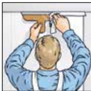
**6.** Die Trennung in den Ecken wird mit der Scheere ausgeführt. Profis reißen die Rauhfaser in den Ecken aber auch häufig mit einem Spachtel zu.
