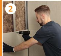
Ständerbauweise: Stoß-an-Stoß-Montage auf einer Unterkonstruktion aus Holz oder Metall.
