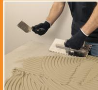
Oder: Verklebung direkt auf die Wand. Dafür die Platte zuvor vollflächig mit Systemkleber RB 10 beschichten.
