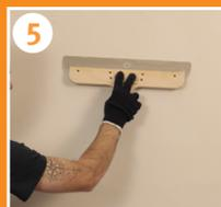
Glätten. Nach Trocknung Unebenheiten anschleifen. Anschließend kann die Fläche tapeziert oder gestrichen werden.
